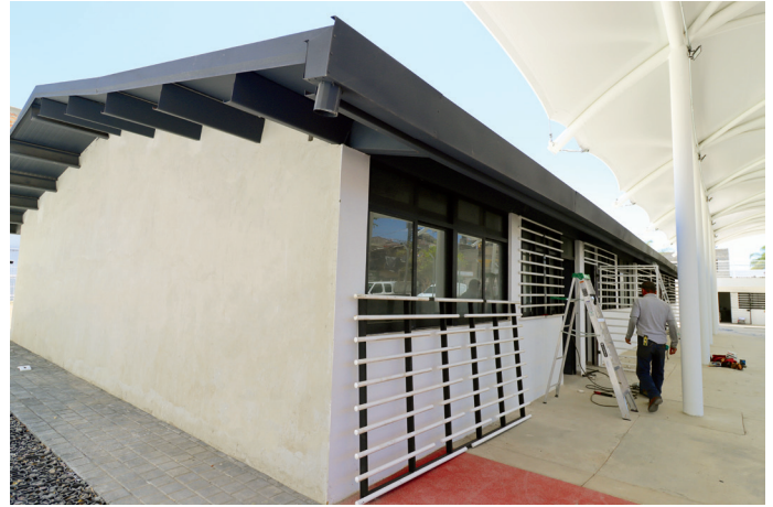
Mantenimiento y rehabilitación de la Habiliteca Miramar
